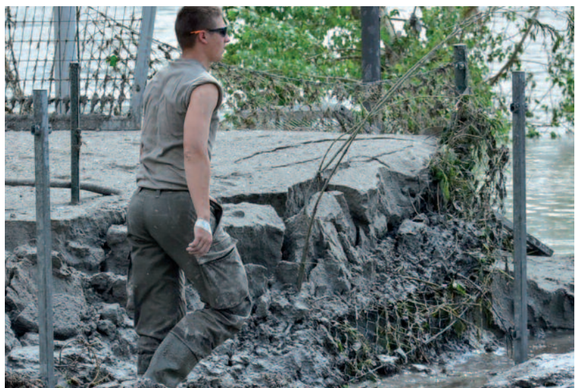
Sedimentablagerungen nach dem Hochwasser 2013 (Quelle: Bundesheer, Miesenböck)
