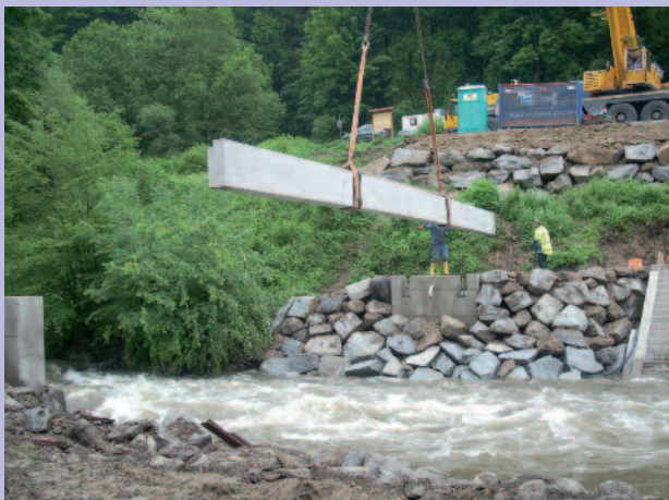
Einbau Messsteg
