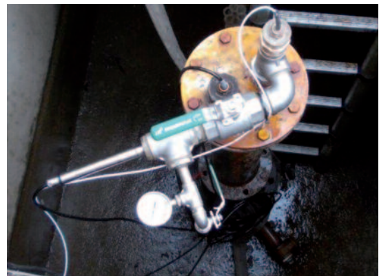
Tiefgrundwassermessung in Reichersberg
